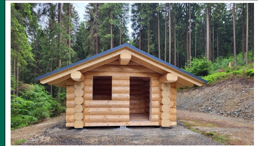
Neue Schutzhütte am Glasbachweg im Revier Zwota
